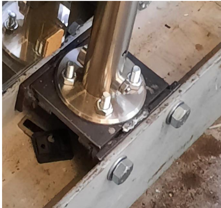
Abbildung 6: Befestigung der Pfosten
