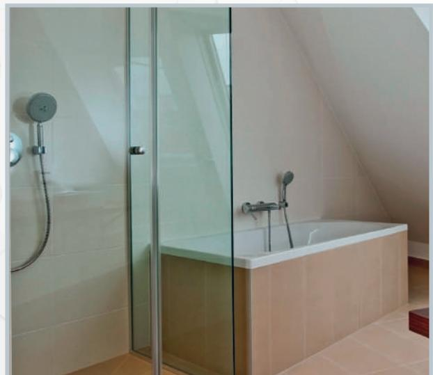
Pour les parois de douche en verre, **des joints de douche** sont installés entre les éléments en verre, dans la zone des charnières et au niveau du sol, afin de **garantir la meilleure étanchéité possible** et **d'éviter les fuites d'eau**. Nos profilés d'étanchéité sont disponibles en transparent ou en noir et peuvent être utilisés pour des épaisseurs de verre de 6, 8 et 10 mm. Une pose supplémentaire de profilés anti-éclaboussures devrait encore minimiser les fuites d'eau.
